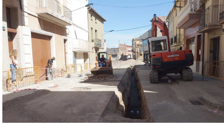
REPARACIÓ DE LA CLAVEGUERA DEL CARRER NOU
